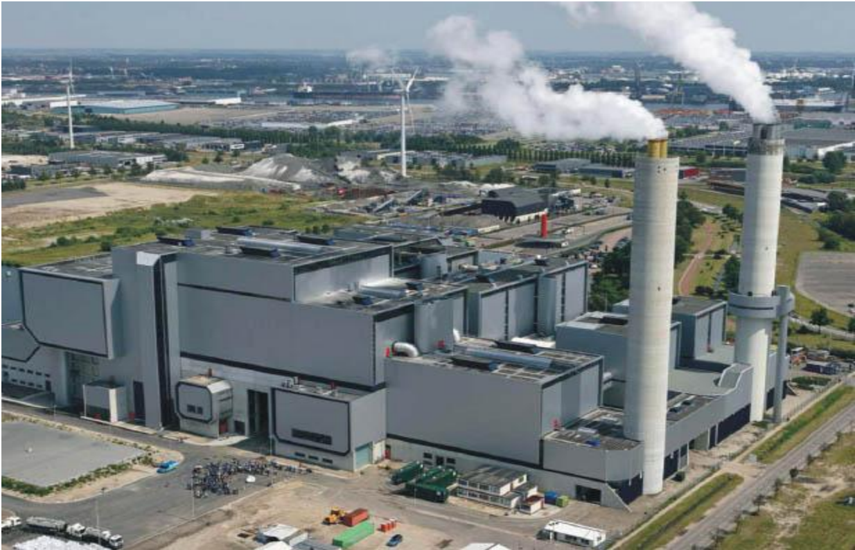
Εικόνα 2: Μονάδα αποτέφρωσης ΑΣΑ (Amsterdam) [6]
